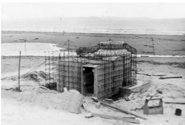
Fig. 2. Bunker tipo Tobruk, struttura ed esempio di costruzione (Creta, 1941). Immagini caricate da Luca Lorenzi nella voce Tobruk (bunker)", it.wikipedia.org/wiki/Tobruk_(bunker) , CC BY-SA 3.0 Wikimedia Com-mons
