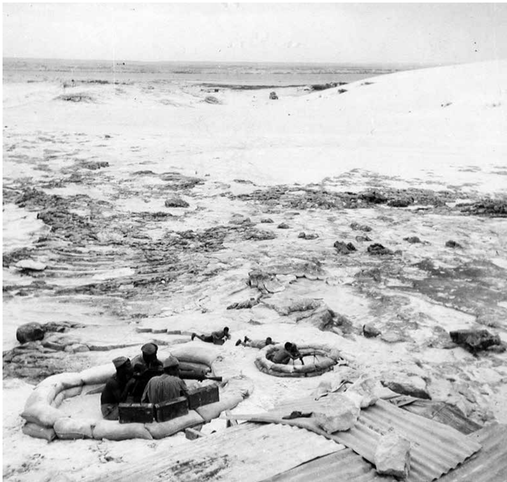
Centro di fuoco sul fronte di Alamein. Poteva comprendere un pezzo contro-carro e una o più armi automatiche, e doveva essere capace di reagire su 360°.
